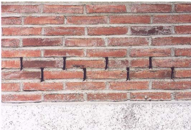
Bild 5: Offene Stoßfugen in zwei Steinlagen als Entwässerungsöffnungen.
